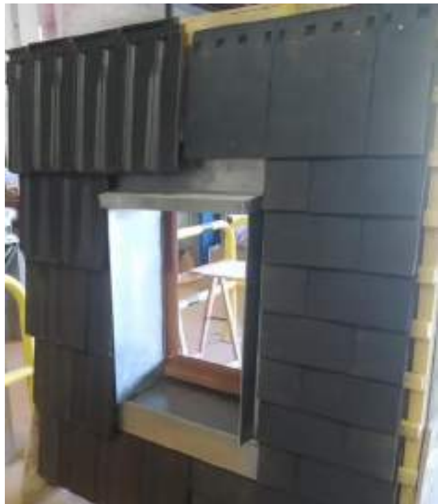
Photographies 1 : Maquette d'entourage de baie pour tuiles plates et tuiles à emboîtement. Ce traitement permet d'isoler la baie des contraintes liées
