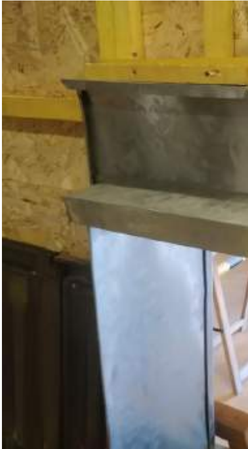
Photographie 7 : Haut de baie pour tuile à emboîtement
