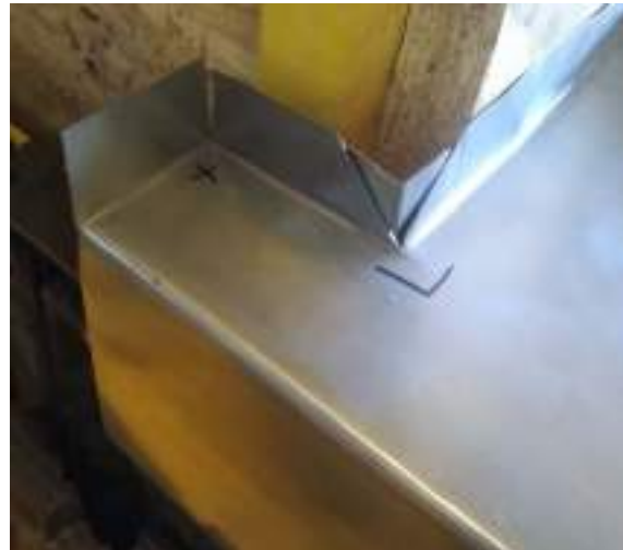
Photographies 2 : détail de bavette basse sur pièce d'appui, avant la mise en place d'un gousset soudé sur l'angle (gauche) et mise en place du gousset à souder et soudures à faire (marques) (droite)
