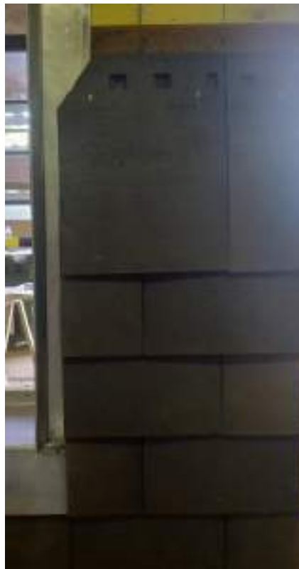
Photographie 9 : Epaulement des tuiles plates en raccordement avec le couloir.
