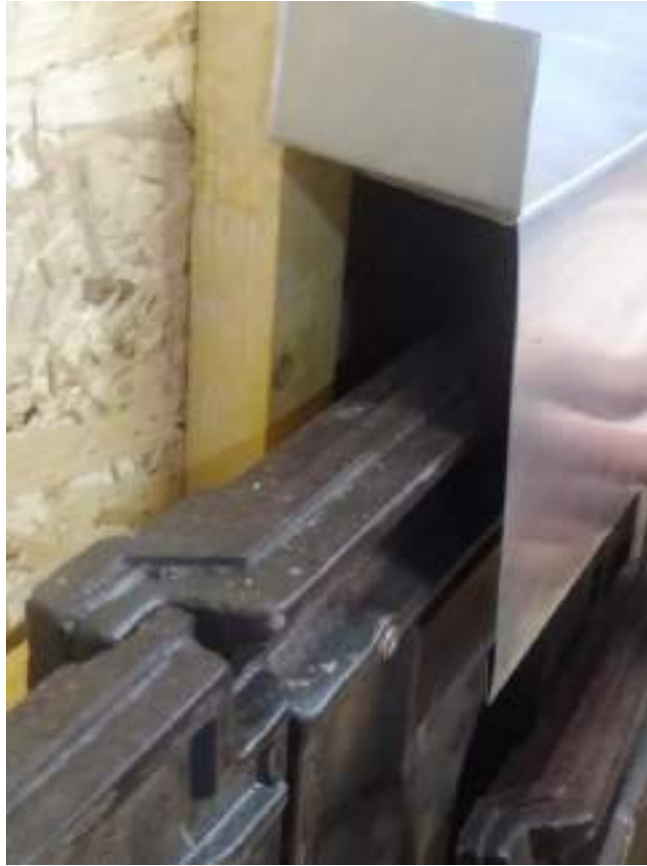
Photographie 3 : Bavette basse en recouvrement sur la tuile de la valeur d'un recouvrement des petits éléments de toiture
