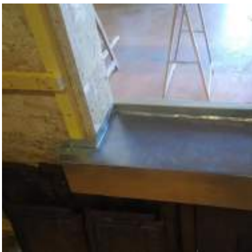
Photographies 2 : détail de bavette basse sur pièce d'appui, avant la mise en place d'un gousset soudé sur l'angle (gauche) et mise en place du gousset à souder et soudures à faire (marques) (droite)
