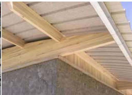
Poutres en lamellé-collé de peuplier (16 m de portée). Aérodrome de Fay (36). ARCHITECTE : DS ARCHITECTURE, ENTREPRISES BOIS : CHARPENTE NATALI, SIMONIN
