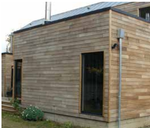
Horizontale à rainure et languette. Permet une continuité dans la paroi et un maintien homogène. (voir p. 43)
