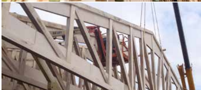
Fermes à gousset contreplaqué, bois massif abouté, charpente de la scierie Le Chênelet (28 m de portée). (62) (voir p.12)
