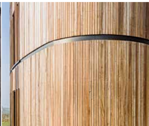
Verticale avec lames de différentes largeurs. Permet d'épouser la forme arrondie du bâtiment. (voir p. 18)
