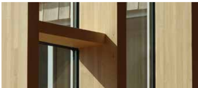
Ossature en lamellé-collé, charpente de la médiathèque, Givenchy-en-Gohelle. (62). ARCHITECTE : STUDIO AP, BET : IPE, ENTREPRISE : BEL'BOIS.
