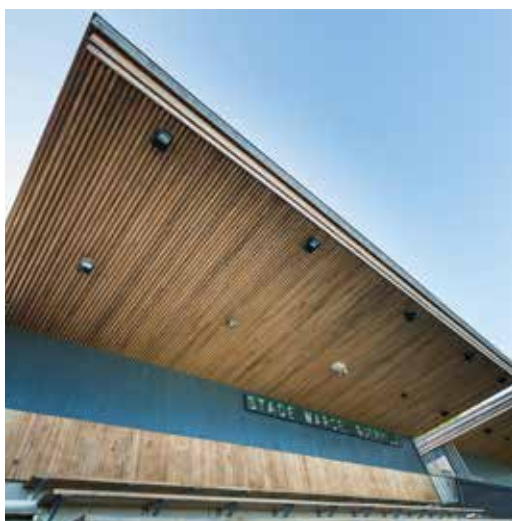
Sous face de tribune en peuplier brut*. Etaples-sur-Mer (62). ARCHITECTE : LAURENT BAILLET, BET : INGÉBOIS STRUCTURES, ENTREPRISE BOIS : AS BOIS
