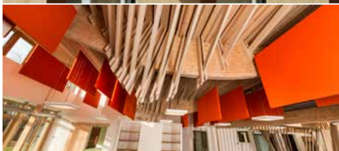
Ossature et charpente, centre de la petite enfance, Courcelles-les-Lens. (62) (voir p.10)
