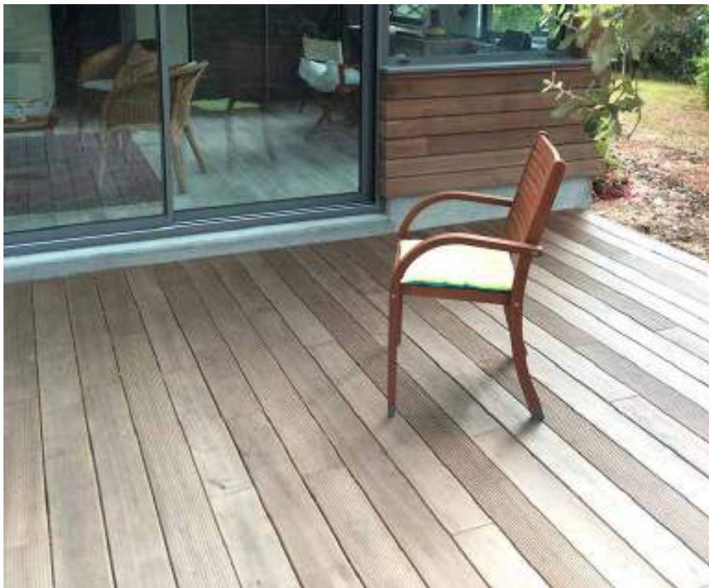
ENTREPRISE BOIS : CENTRE BOIS MASSIF (18)
