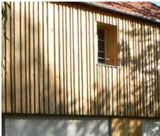
Verticale à recouvrement. Permet l'utilisation d'un profil simple, à coût modéré, raboté ou brut de sciage. (voir p. 19)
