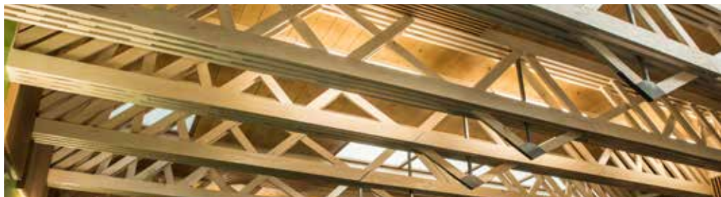
Charpente en peuplier massif de la Salle Polyvalente de Lezennes (59). ARCHITECTE : LAURENT BAILLET, BET : INGÉBOIS STRUCTURES, ENTREPRISE BOIS : AS BOIS
