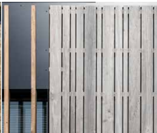
Verticale à claire-voie. Permet un vieillissement homogène. (voir p. 18)
