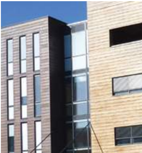
Mixité bardage cuivre et bois sur les locaux de MIPH en mixité bois et béton à Toulouse (31) - Agence Vigneu et Zilio - 2012
