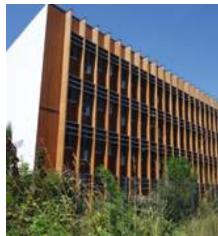
Lasure ambrée sur douglas 3 ans après la pose - Ecole Pigié à Toulouse (31)
