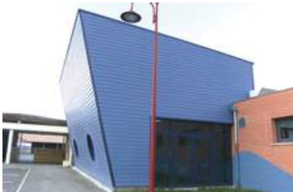
Lames composites fibre et ciment sur l'extension de l'école Eric Tabarly à Saint Lys (31) - Architecte Arcoser
