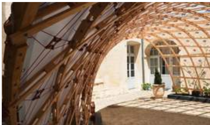
Gridshell à Montpellier (34) - 2016 - Entreprise Quaternion
