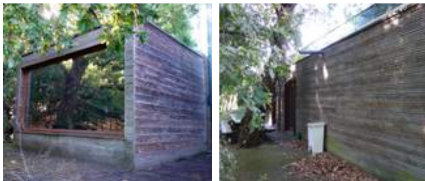
Bâtiment dont la proximité avec la végétation est propice au maintien de l'humidité et au développement de mousses
