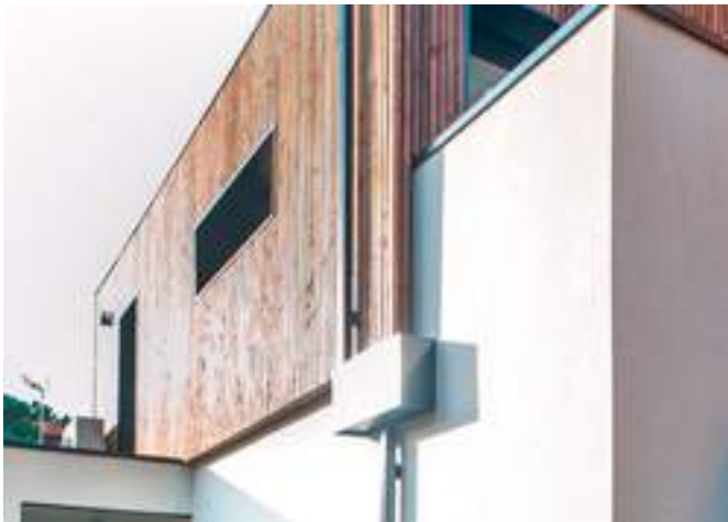
Enduit sur ossature bois en mixité avec un bardage en mélèze pour l'extension d'une chartreuse à Toulouse (31) - Architecte : Atelier Vela - 2015
