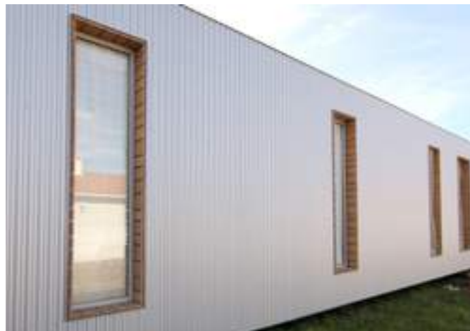
Bac acier en mixité avec un bardage en douglas sur maison individuelle en ossature bois à Lavour (81) - Atelier kit architecture - 2014
