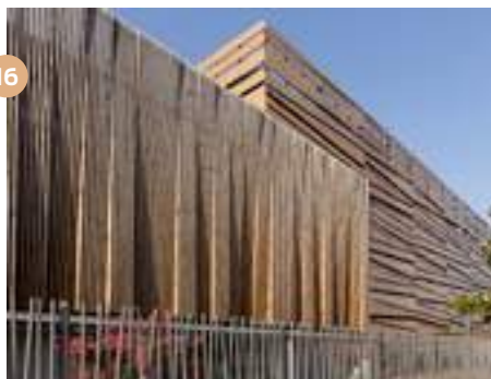
16 - Complexe sportif Capitany à Colomiers (31) - 2014 - Architecte : HBM - ©Marc Mesplé - La façade « piano » très ajourée est doublée d'une façade vitrée qui permet de profiter au maximum de la luminosité extérieure sans pour autant avoir de risques d'éblouissement.
