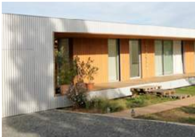
Bac acier en mixité avec un bardage en douglas sur maison individuelle en ossature bois à Lavour (81) - Atelier kit architecture - 2014
