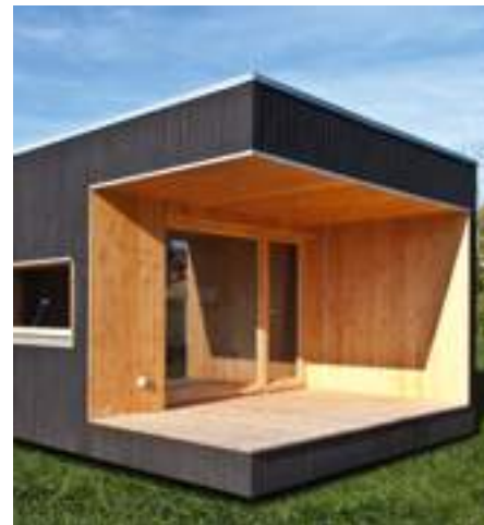
Peinture noire sur bardage douglas Extension AS2 à Larcen (31) Prax Architectes
