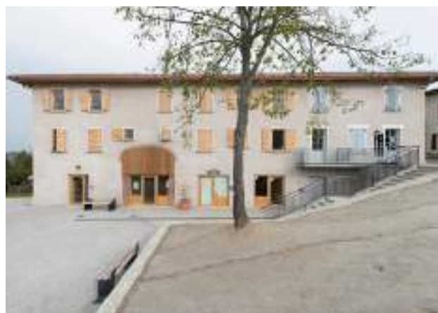
© V. Rigassi – Logements sociaux et commerces – Montseveroux (38)
