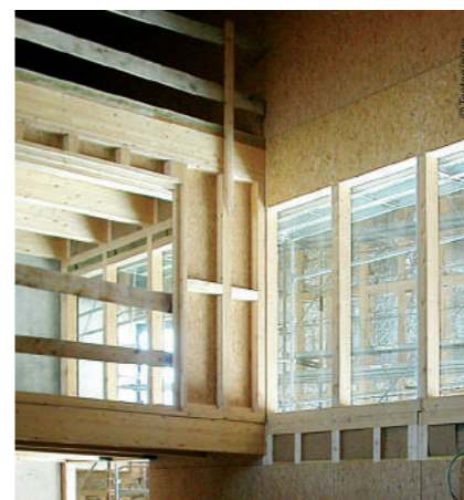
Maître d'ouvrage : Parc naturel régional du Haut-Jura Architectes : Max Rolland - Tectoniques (69), Adelfo Scaranello (25) - BET Bois : CET (69)
