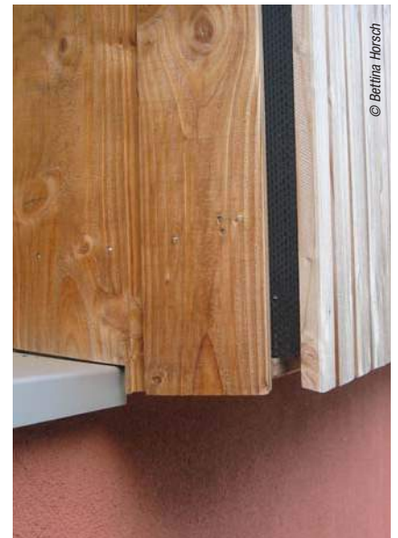
Ici, le joint vertical entre les lames de la façade et celles de l'encadrement de la fenêtre est ouvert, avec une grille anti-rongeur située derrière.
