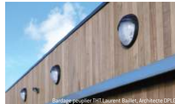
Bardage peuplier THT. Laurent Baillet, Architecte DPLG
