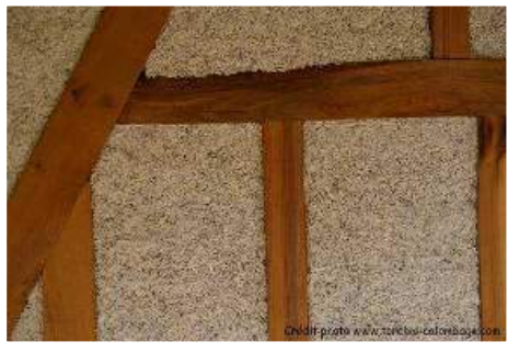
Isolation faite avec du béton de chanvre
