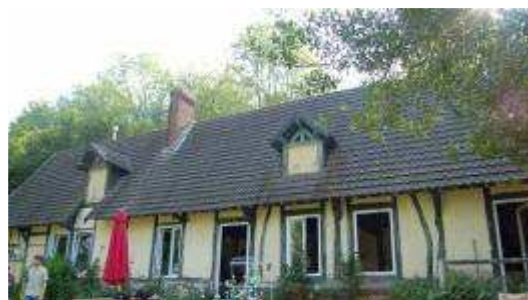
Exemple de maison à pan de bois à Perrier sur Andelle ne possédant pas de gouttière.
