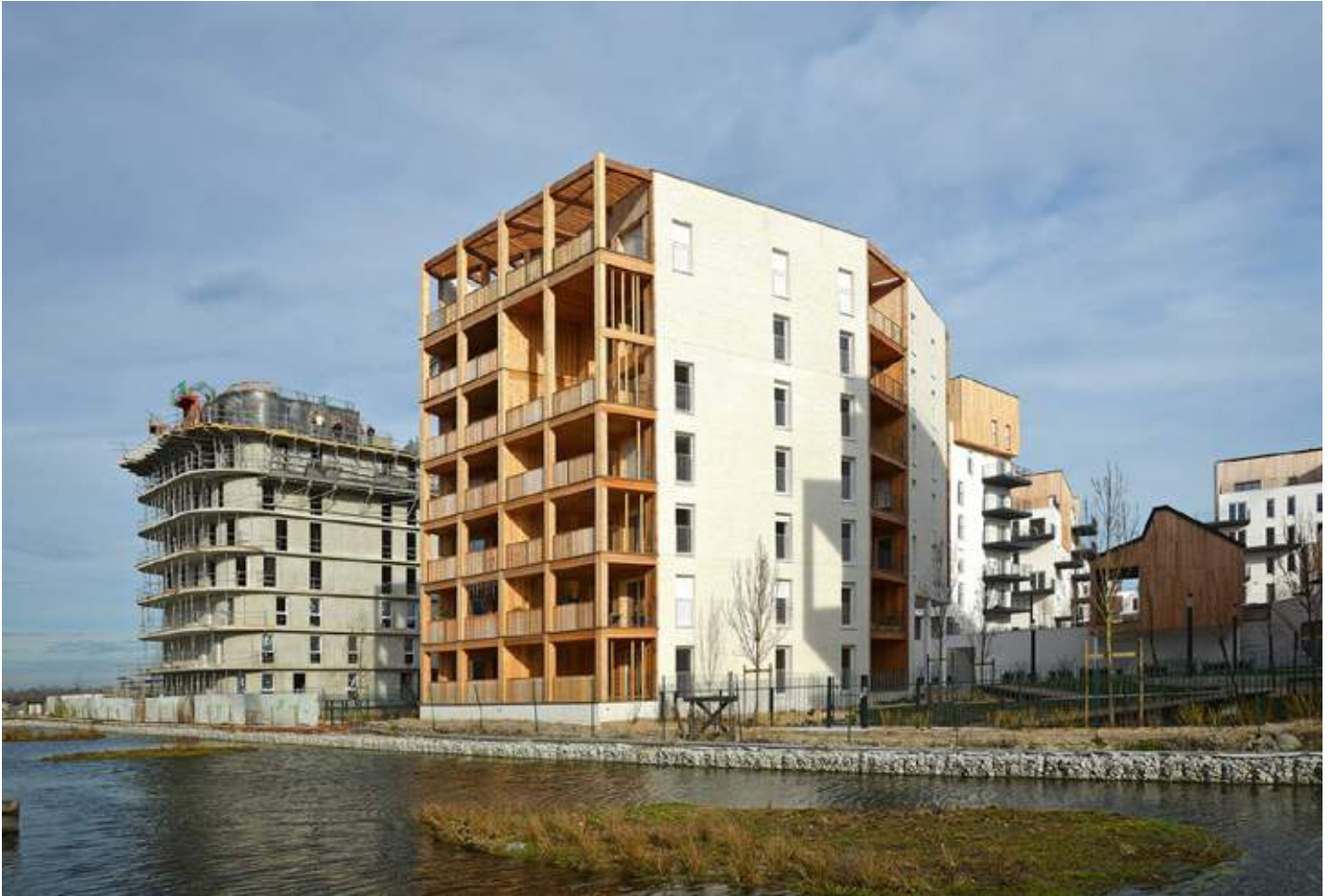
La nouvelle agence, architecte
