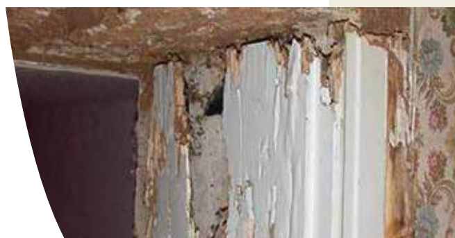
Attaques sur un montant de porte
