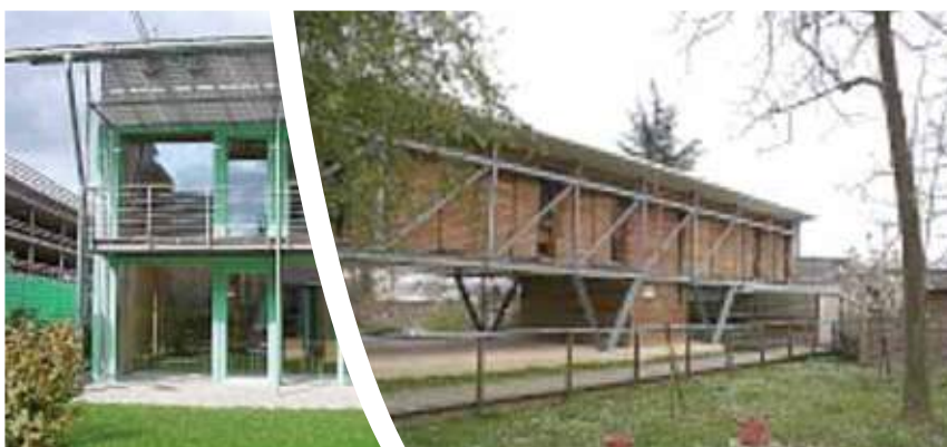
Construction sur poteaux béton
