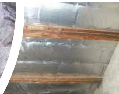
Chevrons masqués par un isolant
