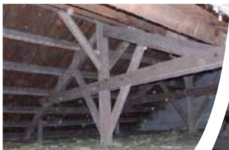
Charpente en combles perdus
