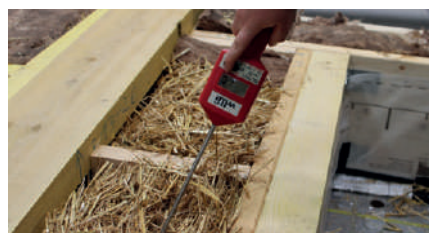
Le taux d'hygrométrie au cœur des bottes doit être mesuré et contrôlé.
