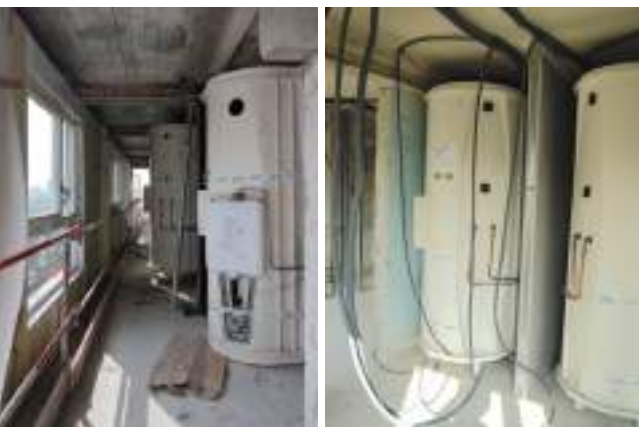
Cabines salle de bain, préfabriquées aux cotes des nouvelles chambres, 90 cm intérieur.
