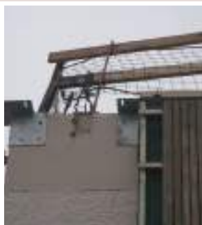
Ferrures fixées sur l'acrotère, en attente de recevoir les panneaux.
