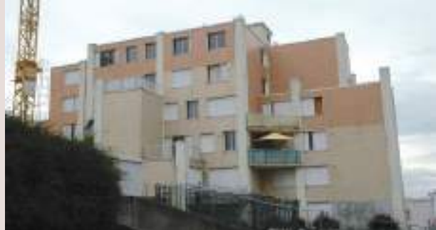
Façades avec ITE des années 80.
