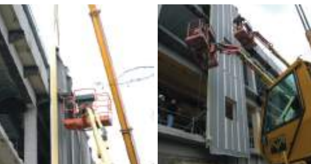
Fixation des panneaux en partie haute et basse.
