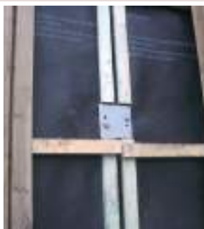
Liaison entre panneaux par platine se faisant sur la face extérieure du panneau. Puis 4 lames de raccord seront posées sur chantier.
