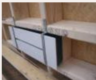
Le système d'entrée d'air, avec filtre acoustique, est dissimulé dans l'ossature bois pour chaque chambre, évitant ainsi la présence visuelle d'une grille en façade.
