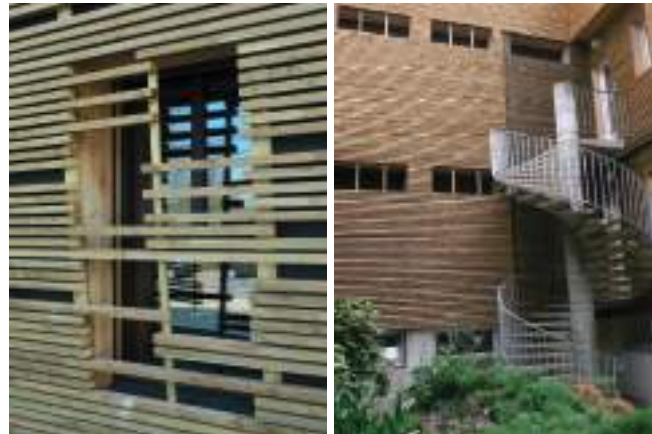
Façade ouest, tasseaux bois formant brise-soleil. Les allèges vitrées redonnent une vue aux élèves en position assise.
