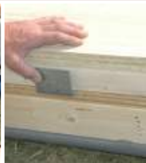
Installation de la laine de roche et de l'équerre de guidage qui sera glissée dans la réservation prévue dans le panneau supérieur.
