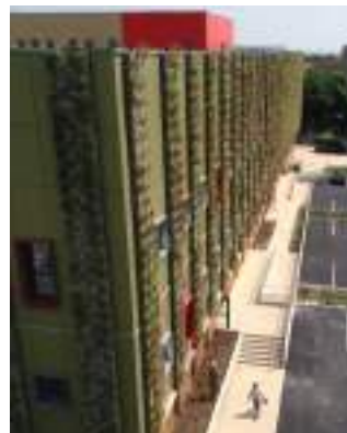
Façade sud, panneau composite et végétalisation.
