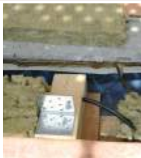
Installation de la laine de roche et de l'équerre de guidage qui sera glissée dans la réservation prévue dans le panneau supérieur.
