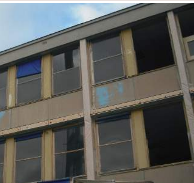
Les supports intermédiaires BLC sont fixés préalablement sur les nez de plancher, simultanément à la dépose des fenêtres.
