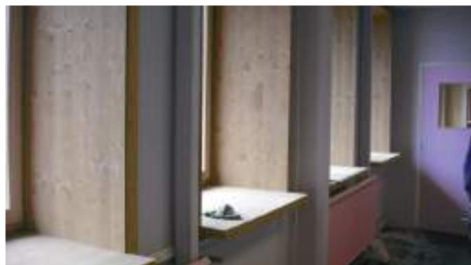
Les tableaux des menuiseries sont habillés de panneaux multiplis prédécoupés en atelier.
