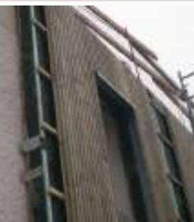
Fixation à mi-hauteur des panneaux par équerre afin de les reprendre sur le mur existant.
