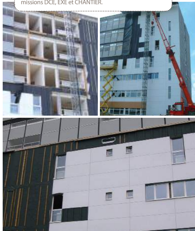
Le calepinage de la vèture ne correspondant pas aux dimensions des panneaux bois, les panneaux fibre-ciment sont posés in situ.
