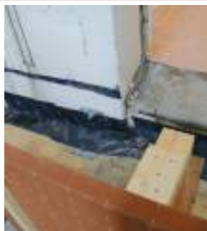
Calfeutrement des panneaux inférieurs par bande adhésive.
