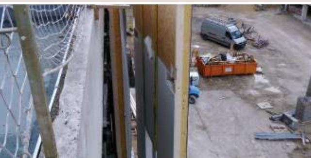
Réservations dans les panneaux ossature bois pour fixation.
