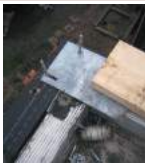
Ferrure mécano-soudée, reprenant les panneaux inférieurs et supérieurs. Calage de la lisse de ceinturage.
