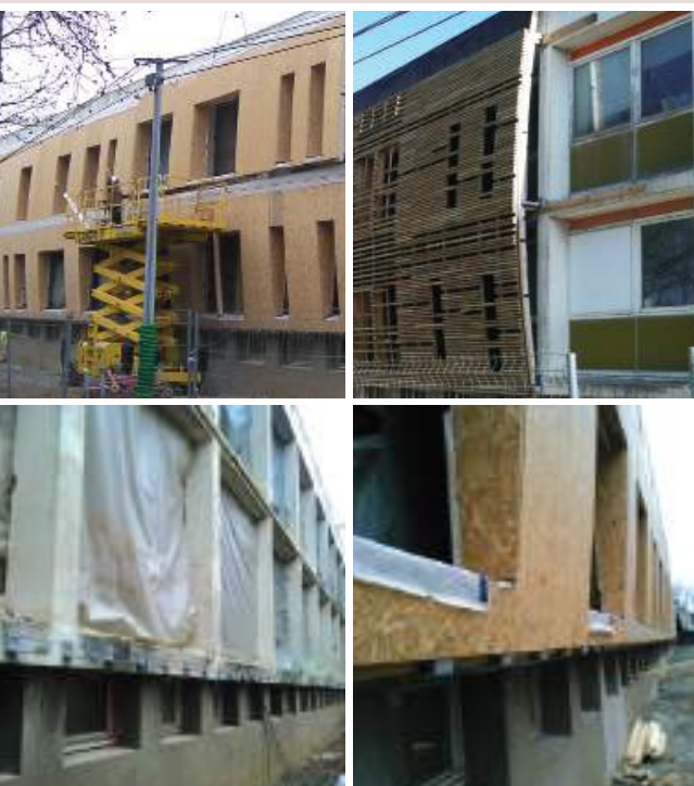
En pied de façade, les panneaux sont ancrés sur des ferrures en « U ».
