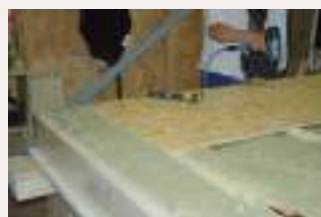
Panneaux de 4 à 12 m x 2,80 m, couvrant à minima la longueur d'une trame de poteau. Poids de 600 kg à 1,1 tonnes.
