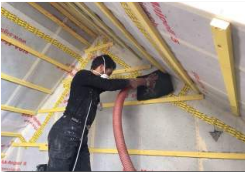
Aviso76 pratiquant la ouate de cellulose insufflée
