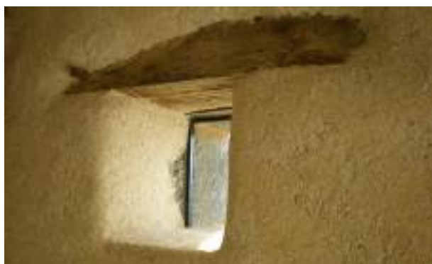
Enduits appliqués à la truelle
