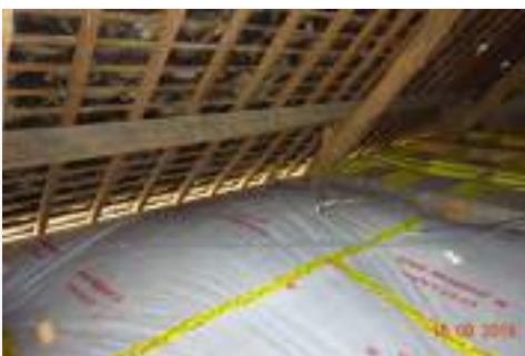
Test d'étanchéité à l'air - Crédits photo : Nicolas Knapp
