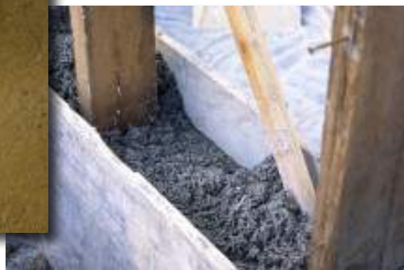
Chaux-chanvre banché dans une ossature
