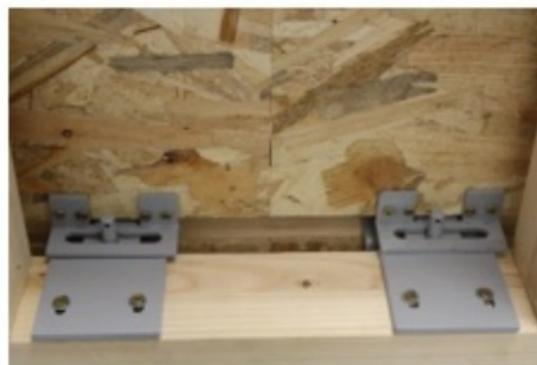
Insertion de la poignée au niveau de l'axe vertical de la platine support. Déplacement horizontal parallèle à la façade, possible de +/- 57 mm
